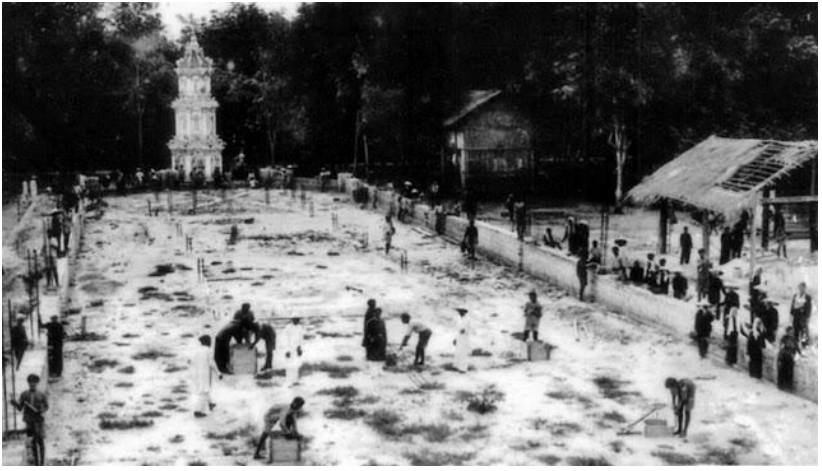
ĐÀO MÓNG CẤT TÒA THÁNH
